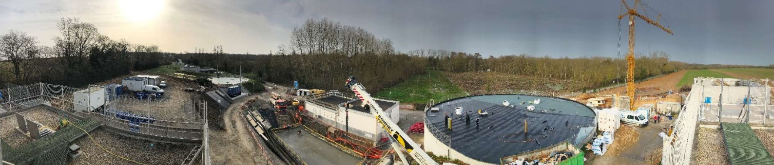
Vue panoramique des travaux réalisés à l'usine de Beaulieu.
